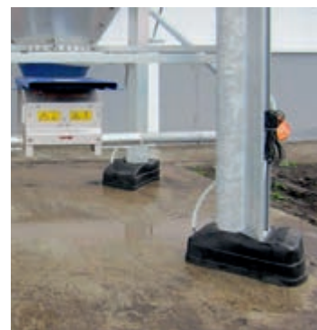
Tutup kaki silo untuk melindungi timbangan saat cuaca ekstrim
